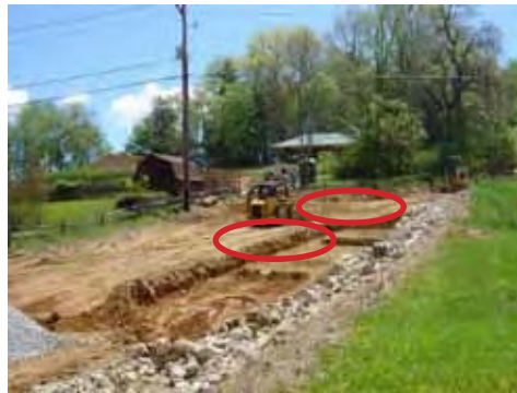
Figure 8. L'illustration du haut montre l'utilisation d'un système de remblais de déviation sous la chaussée. La photo de gauche montre l'installation de remblais de déviation sous une voie d'accès. Les remblais de déviation sont entourés en rouge. La photo de droite montre l'installation de sol structural sur ces remblais de déviation.
