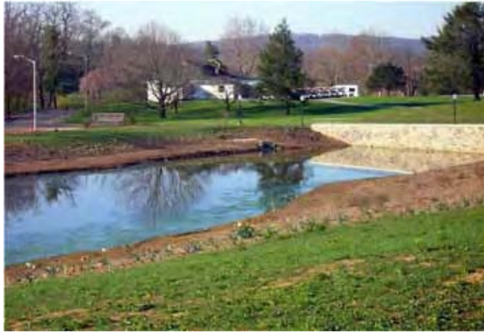
Figure 3. Exemple de bassin de rétention/stockage à proximité d'un centre de conférences sur le campus de Virginia Tech à Blacksburg, en Virginie. Ce traitement utilise un espace qui pourrait autrement servir à d'autres usages.
