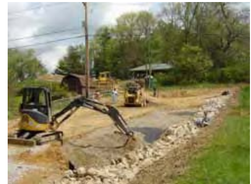
Figure 8. L'illustration du haut montre l'utilisation d'un système de remblais de déviation sous la chaussée. La photo de gauche montre l'installation de remblais de déviation sous une voie d'accès. Les remblais de déviation sont entourés en rouge. La photo de droite montre l'installation de sol structural sur ces remblais de déviation.
