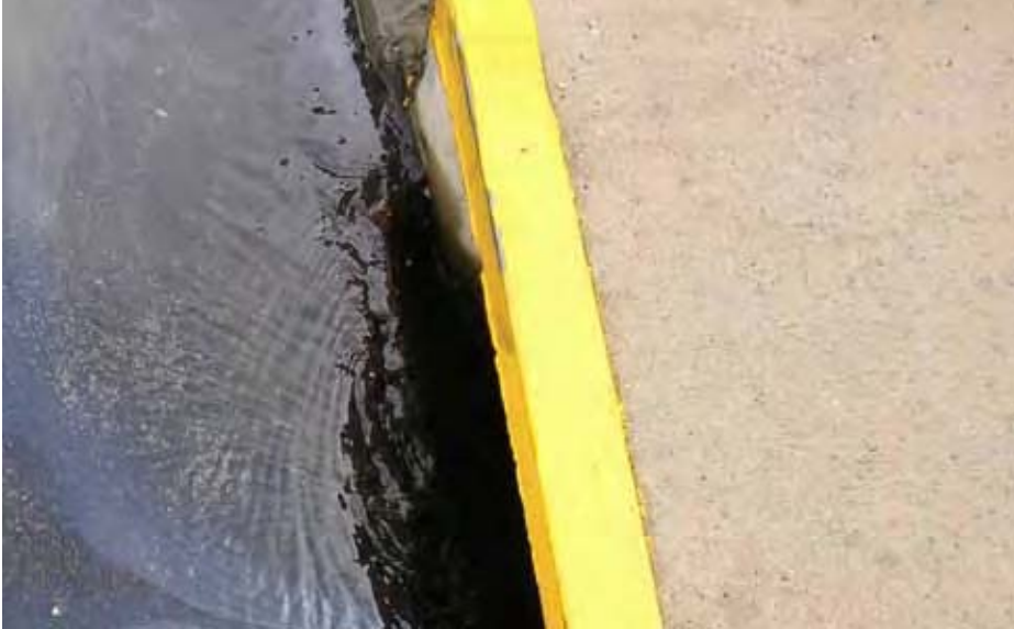
Figure 1. Eaux de ruissellement typiques d'un stationnement s'écoulant dans un égout pluvial. Des traces d'huile sont visibles à l'œil nu. Les eaux de ruissellement des stationnements contiennent plusieurs autres polluants tels que divers métaux, des sédiments, du sel et des débris.
